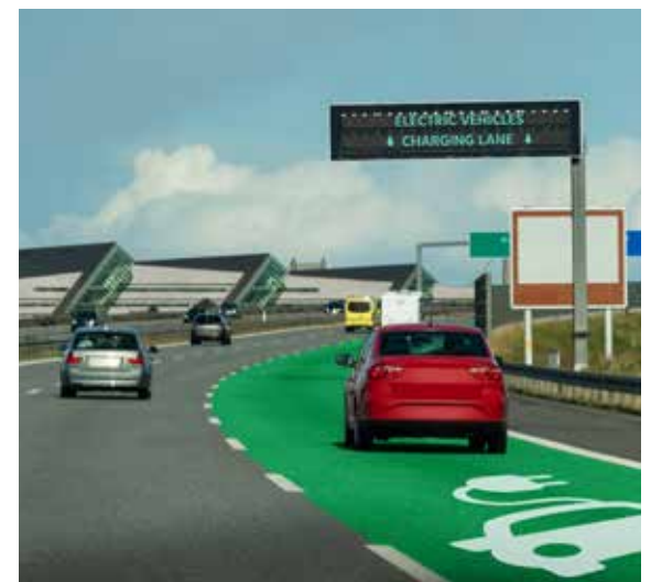
Elbilar laddas under körning med hjälp av särskilda kabelslingor i vägbanan.
